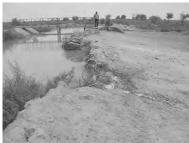
S3水路橋周辺（P1右岸）
