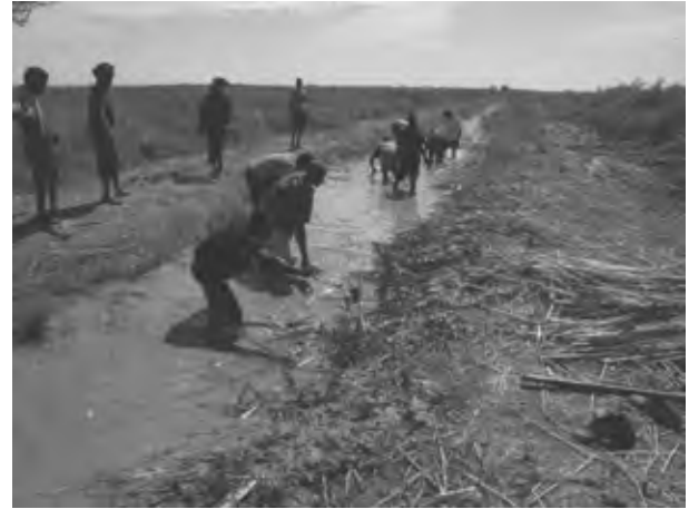
浚渫（水路清掃）の様子
