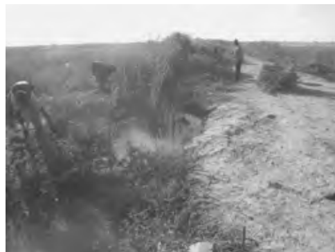
浚渫前の2次水路
