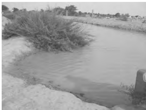
AD水路橋直下流（AD左岸）
