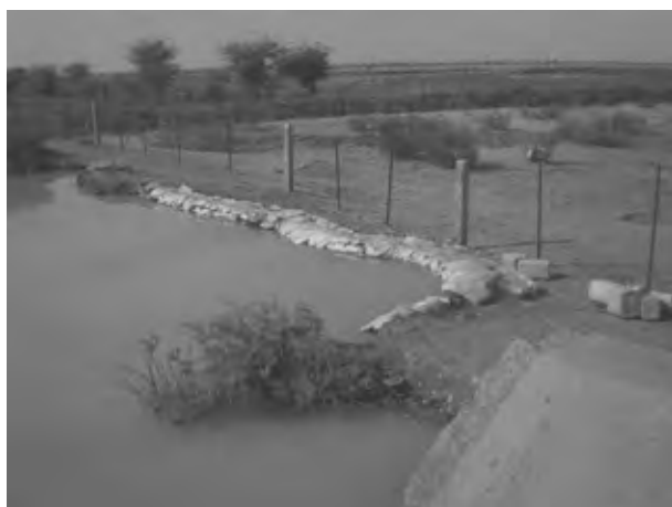
土のうによりかさ上げされた箇所(S3)
