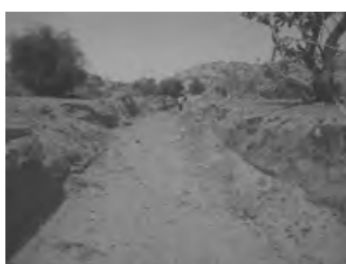
OA導水路始点左岸排水溝掘削
