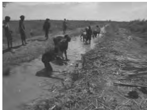
浚渫(水路清掃)の様子
