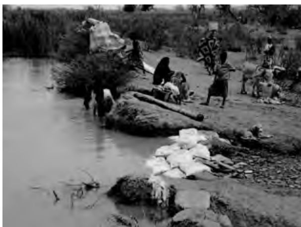
調査団も加わって補修された状況
