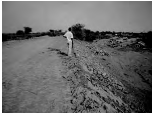
橋梁直下流の堤防盛土工事完了
