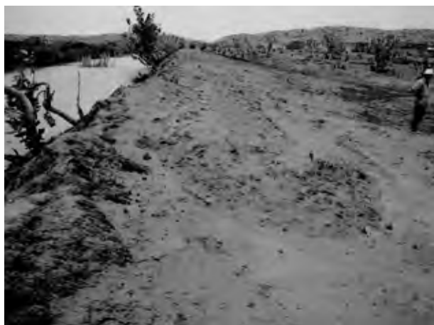
補強された堤防 (OA)
