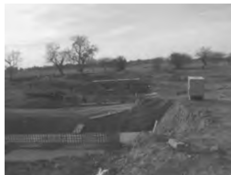
道路橋建設 (カエディ-ムブート間)
