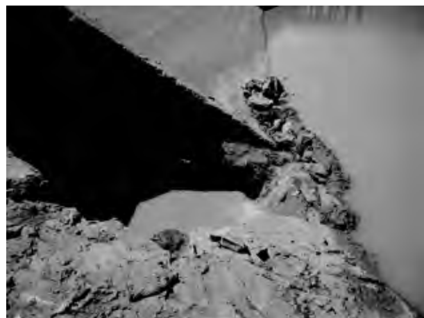
サイフォン7直上流の破堤
