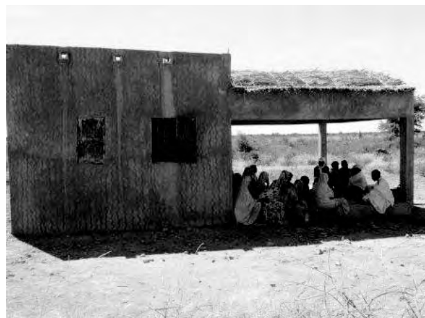
多目的施設の設置
