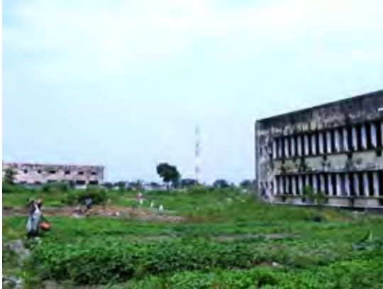
写真-1 対象敷地状況（2010年3月） 対象敷地内に残る旧キンシャサ保健人材センター（写真右）。前面の畑は、着工に伴い撤去することが合意されている。
