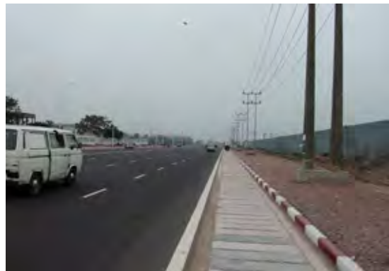
写真-8 対象敷地前面道路（2010年7月） 敷地北側前面道路。中国の支援により整備された。
