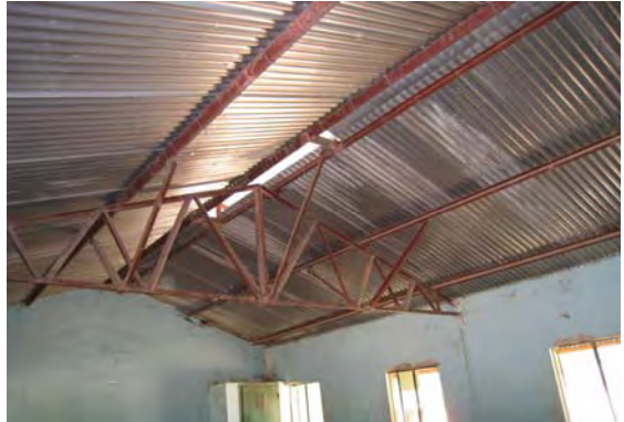
屋根下地が鉄骨造
