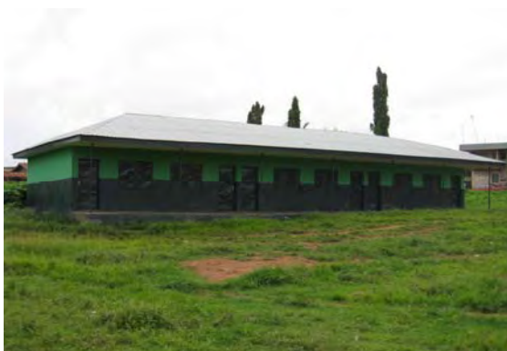
新しい教室棟外観 （LGAにより2007年完成）
