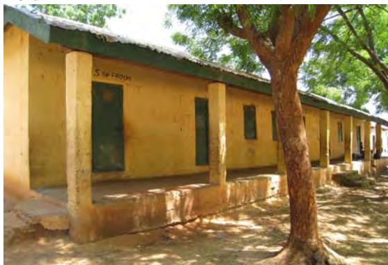
教室棟外観 (1976 年建設の古い建物)
