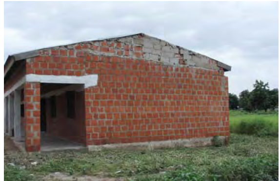
詳細設計のない妻壁上部の施工状況
