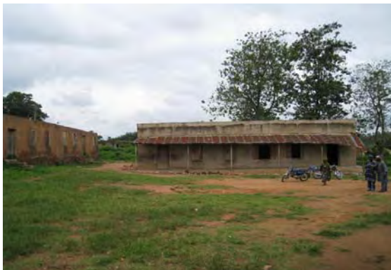
古い教室棟外観 （左側は廃墟となった校舎）
