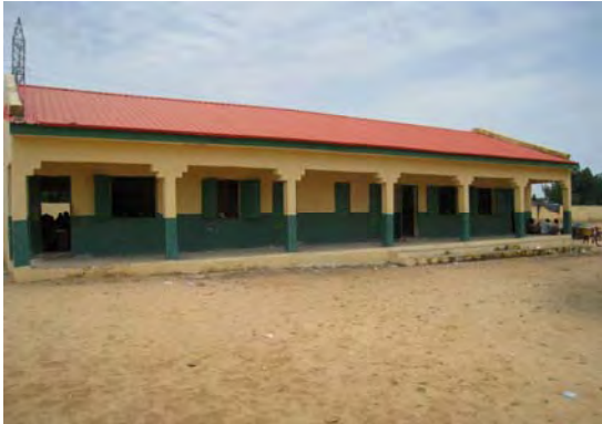
教室棟外観 （2007 年建設）
