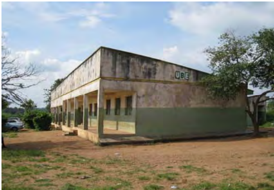
教室棟外観 （2000年、UBEにより建設）
