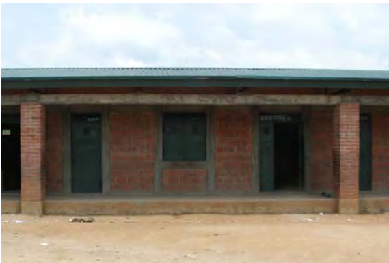
一般無償（第一次計画）による教室棟の廊下部分
