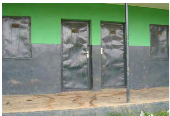
廊下部分の建具
