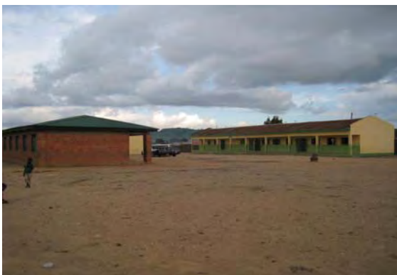
教室棟外観 (左側が一般無償による校舎)
