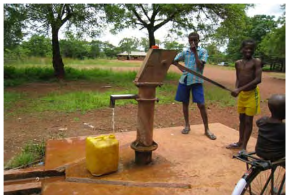
学校用の井戸 （無償資金協力により1993年に完成）
