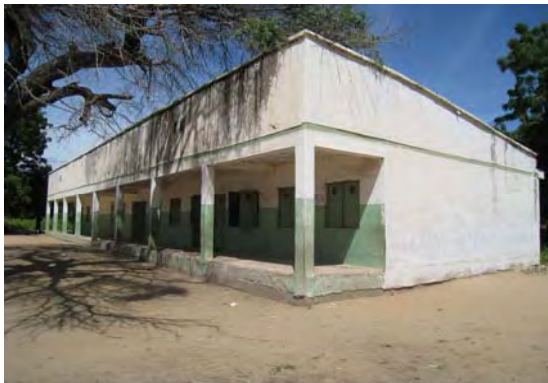
4 教室棟外観 （2004 年建設、UBEC の標準設計）
