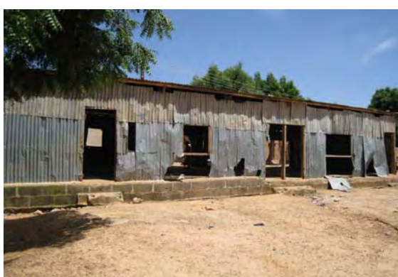
鉄板ぶきの仮設教室
