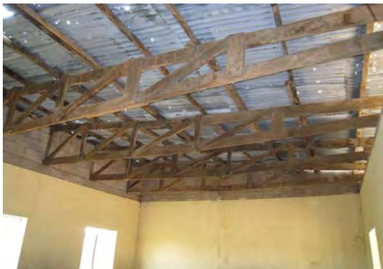
古い教室棟の内部 （簡易な木造トラス）
