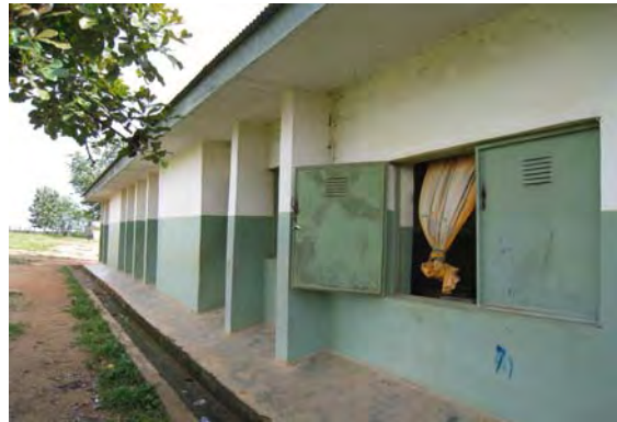
教室棟背面 （外壁の状態が良い）
