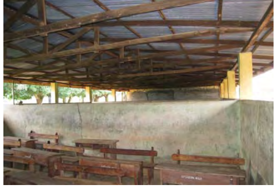
教室内部 （外壁と教室間仕切りは腰までの高さ）
