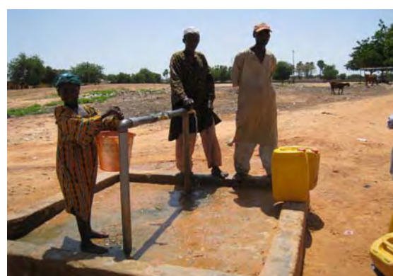
2001 年 1 月完成の学校近くの給水場 (ソーラーシステムを利用した深井戸)
