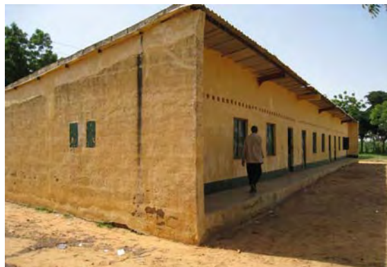
教室棟外観 (1972 年建設)
