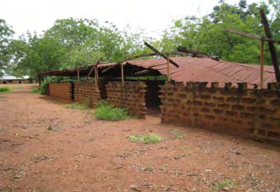
教室棟外観 （かなり老朽化）
