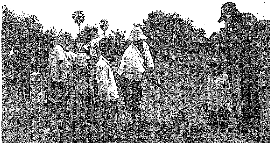
Actividades de rehabilitación de canales.
