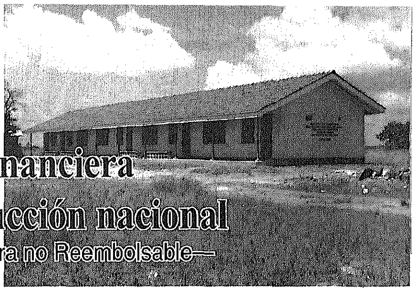
Escuela primaria construida por el Proyecto para el Desarrollo de Instalaciones Escolares para las Escuelas Primarias en Dar es Salaam, en Tanzania.
