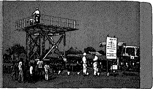
Site de construction d'un système d'alimentation en eau : la mise en place d'une infrastructure de base est une tâche urgente au Soudan (étude d'urgence sur la planification et l'aide à la mise en place d'une infrastructure physique et sociale dans la ville de Juba et ses environs).
