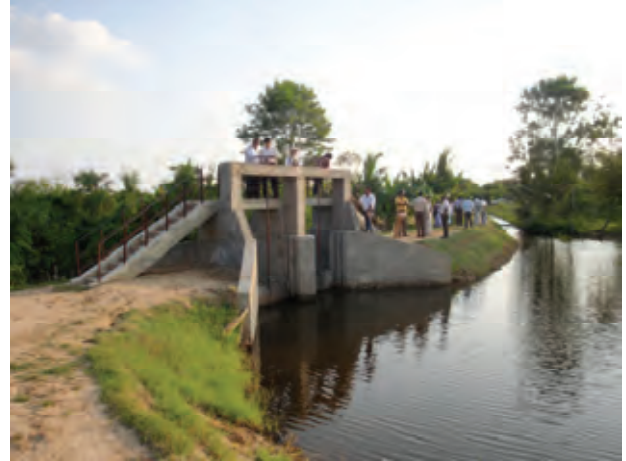
2. 住民コントラクトで改修された頭首工の視察
