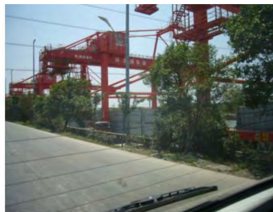
6. 老港廃棄物埋立処分場 (船舶による搬入設備)
