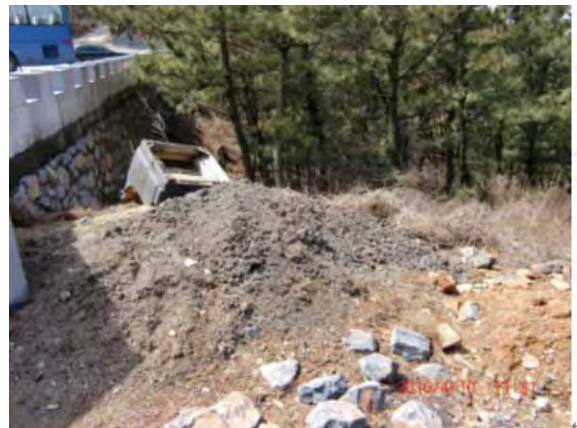
4. 廃棄物の違法投棄(駐車場傍)
