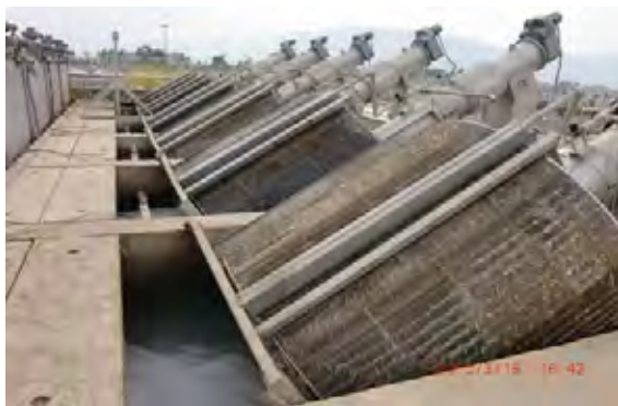
7. 第7下水処理場（細目スクリーン、中国製）
