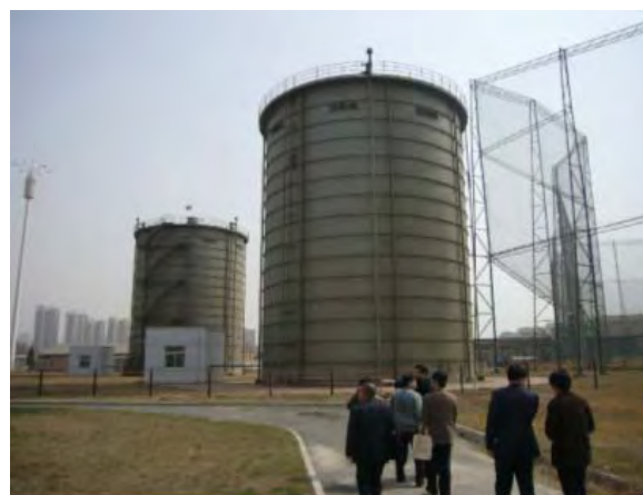
6. 紀庄子污水处理場（消化ガスのホルダー）
