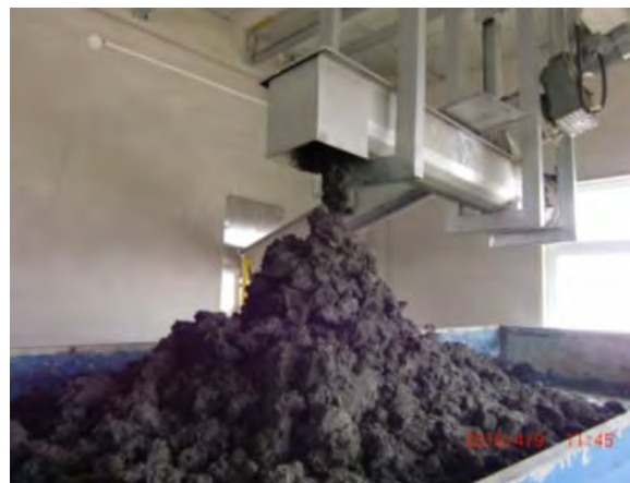
6. 清本再生水有限公司処理場 (脱水ケーキはトラックに仮置き。満杯時に集中処理施設へ搬送)
