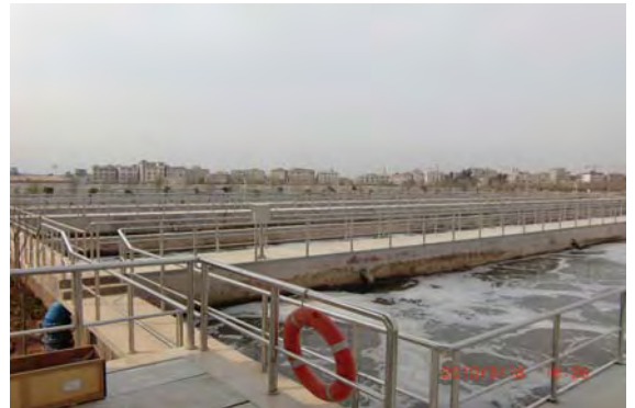
8. 第7下水処理場（曝気槽、試運転中）
