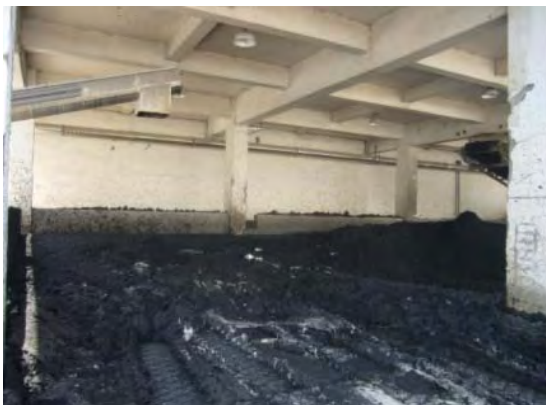
5. 南汇污水处理場（脱水ケーキ搬出）
