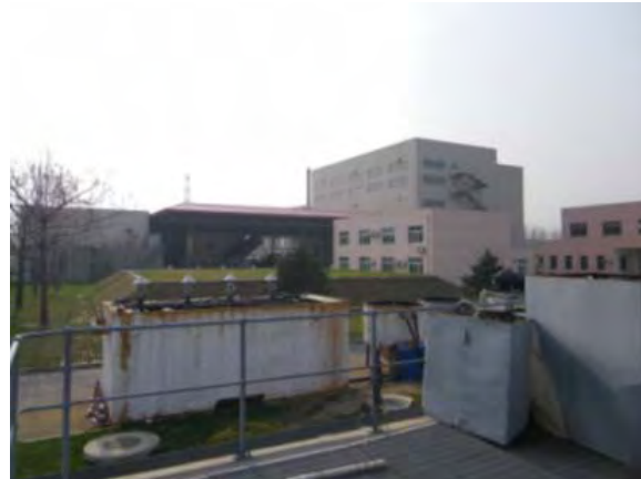
2. 清河污水处理場（奥の大きな建物：乾燥施設） （手前：担体のパイロット実験）
