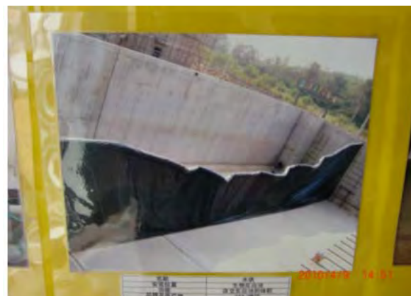
5. 東泰・夏家河污水处理場 （分離カーテンの施工状況）
