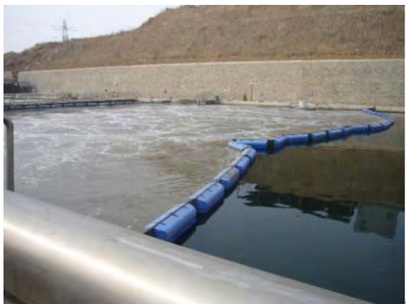
3. 東泰・夏家河污水处理場 （回分式活性汚泥法／曝気プロセス）
