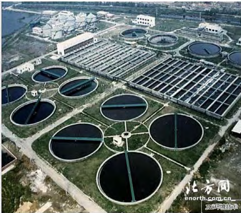
図 8.4.4 紀庄子污水处理場の上空写真
