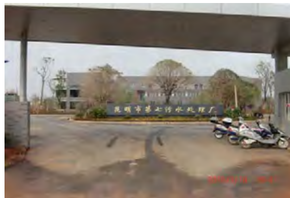
6. 第7下水処理場（入口）
