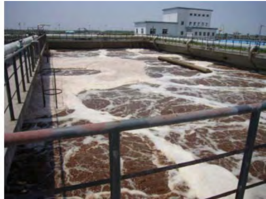
2. 老港廃棄物埋立処分場浸出水処理施
