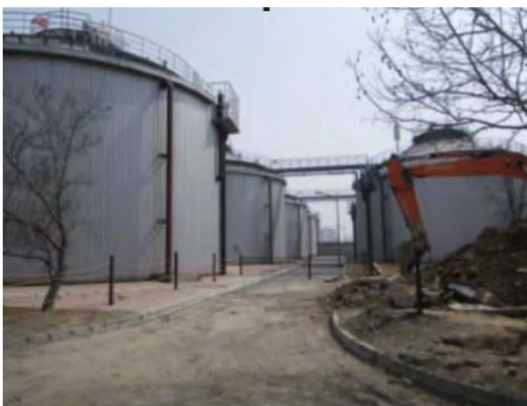
5. 紀庄子污水处理場（消化槽）
