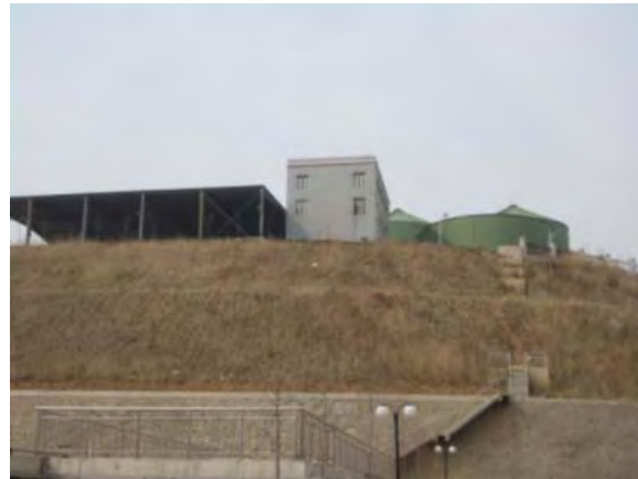
2. 東泰・夏家河污水处理場 （隣接（丘上）の汚泥集中処理施設。ここに余剰汚泥を圧送）
