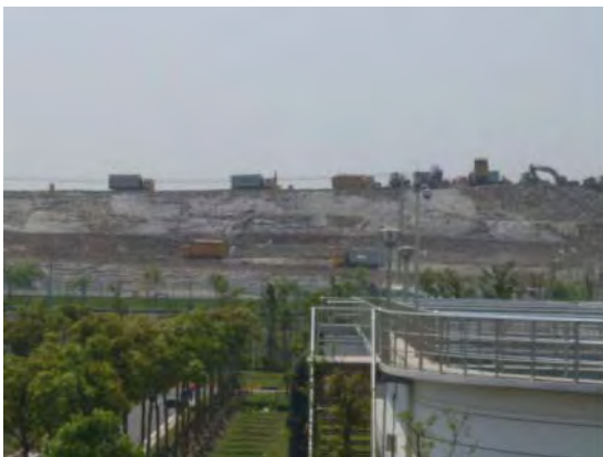
5. 老港廃棄物埋立処分場浸出水処理施設 (埋立状況)
