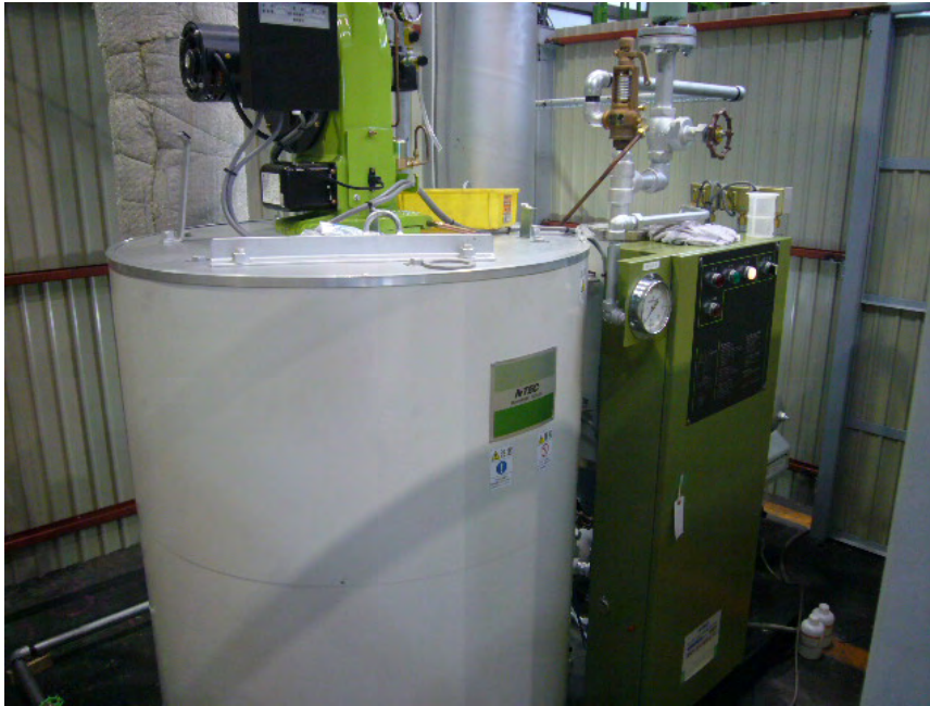
写真 7.1.2 亜臨界水反応処理器(ボイラー部)
