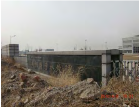
1. 咸陽路污水处理場（入場妨害の土砂）
