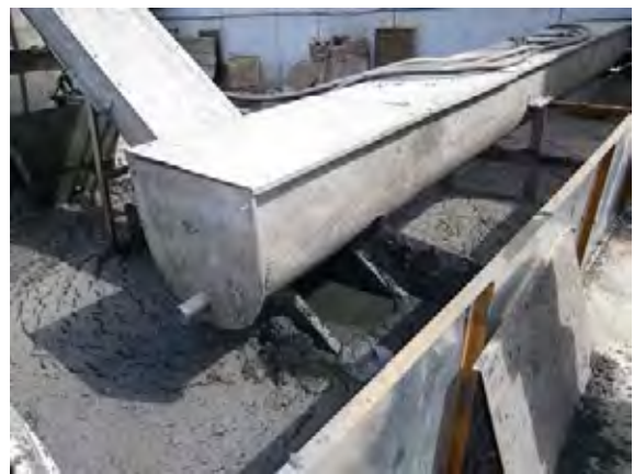
4. 紀庄子污水处理場（遠心脱水後のケーキ）
