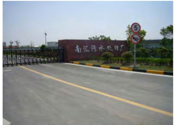
2. 南汇污水处理場（水处理施設）
