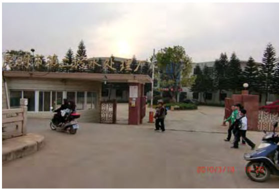
1. 第2下水処理場（入口）
