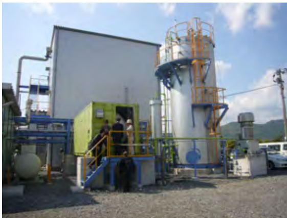
写真 6.2.3 実証試験施設外観
