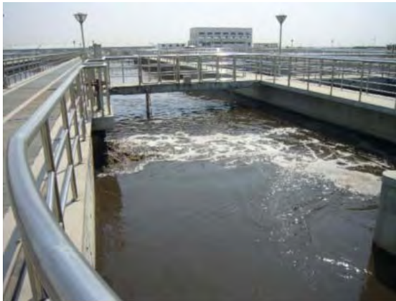
1. 南汇污水处理場（入口）
