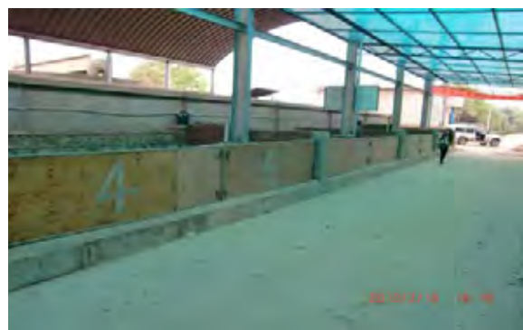
4. 第2下水処理場（脱水汚泥堆肥化実験）
