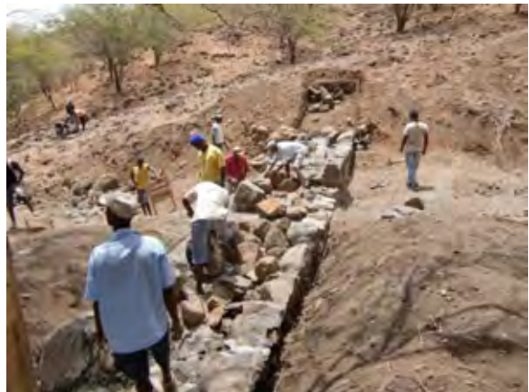
Construção de Dique de Pequena Escala (Desenvolvimento de Pequenos Pontos de Captação)
