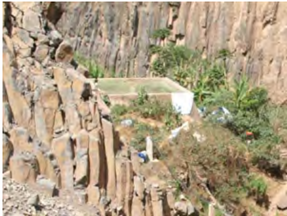
Reservatório Inferior do Dique de Captação de Água Corriente Subterrânea
