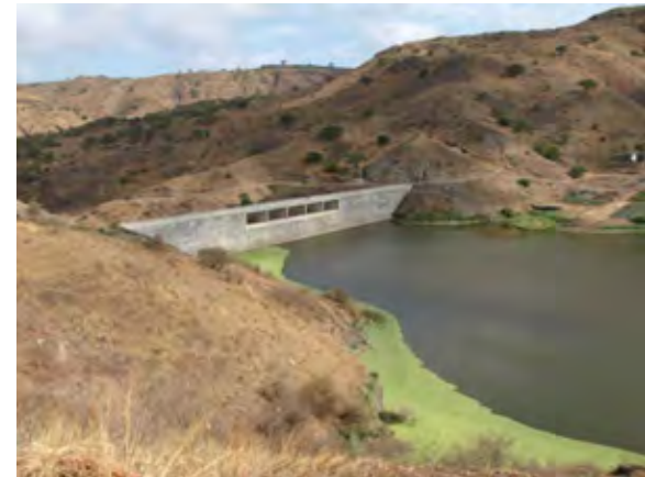
Represa Construída pela Cooperação da China (Seca Bacia Hidrográfica)
