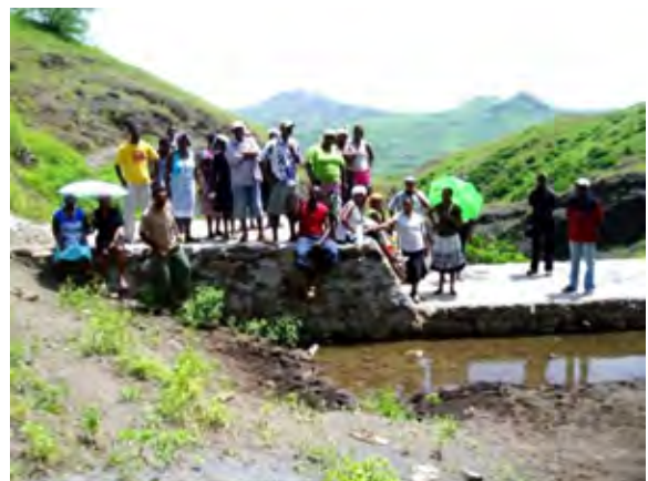
Terminado Dique (Desenvolvimento de Pequenos Pontos de Captação)
