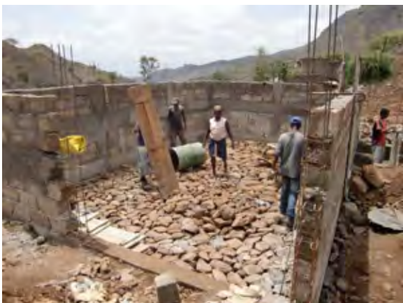
Construção de Reservatório (Desenvolvimento de Pequenos Pontos de Captação)
