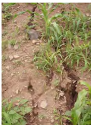
Danos Provocados pela Erosão em Sulcos (A parte superior da foto corresponde à de montante do talude.)
