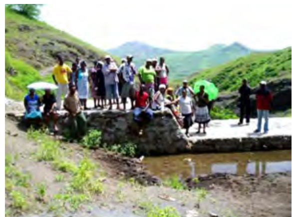
完成した堰 (小規模水源開発計画)
