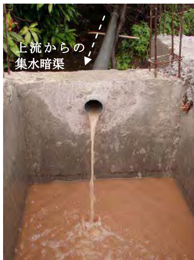
左：路上における集水状況
