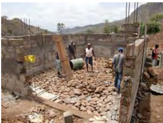
貯水槽の建設 (小規模水源開発計画)
