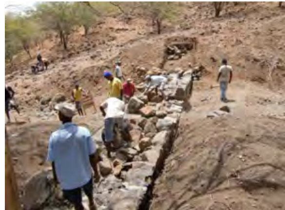
小規模堰の建設 (小規模水源開発計画)
