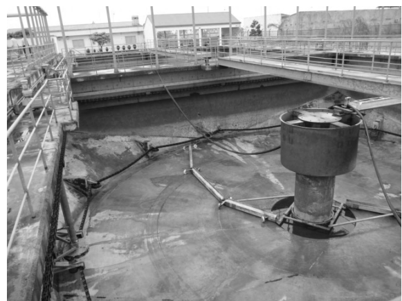
Figure 3.2.43 FST scraper
