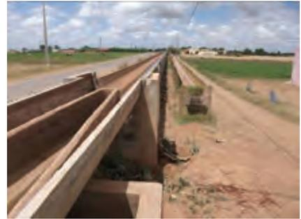
低位部灌溉地域の用水路、以前の用水路の老朽化により、左横に新設している。
