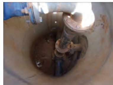
写真 2-2-17 立ち上がり管内部
