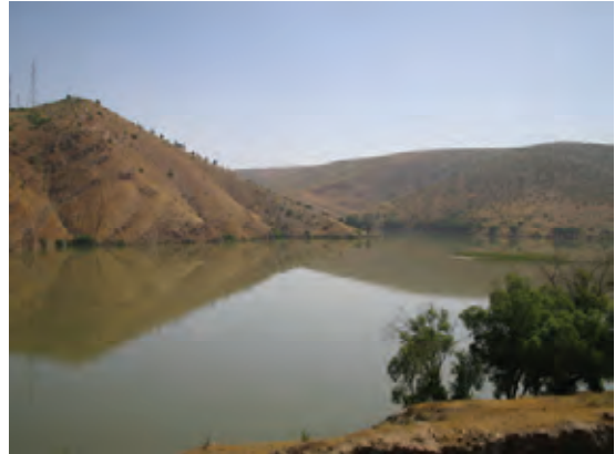
イムフート・ダム
