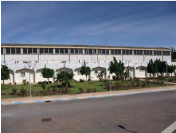
写真 2-2-3 ポンプ場建物
