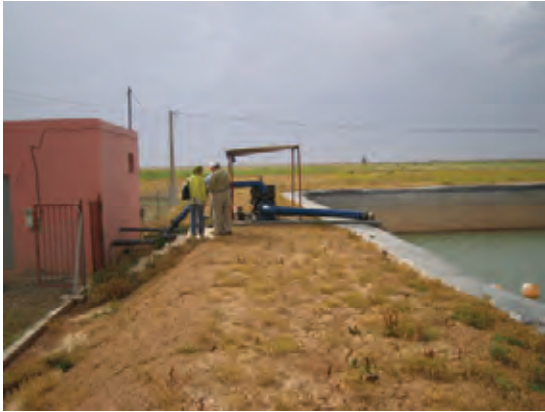
FAO ドリップ灌漑プロジェクトサイト (ファームポンド、ポンプ)
