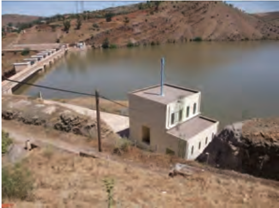
イムフート (Imfout) ダムと高地サービス取水施設
