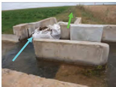
写真 2-2-15 分水工（四次水路へ：土水路）
