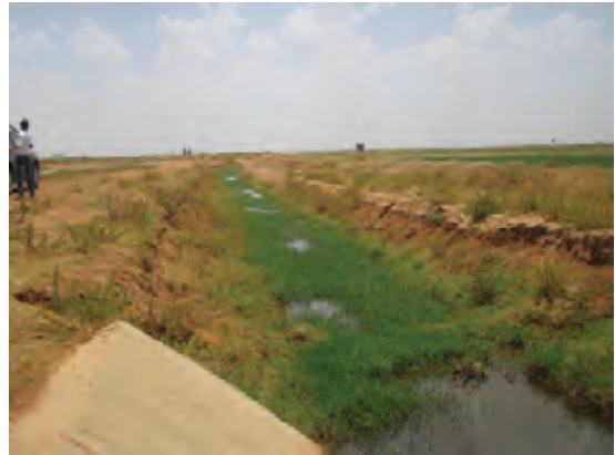
円借款整備地区（排水路）
