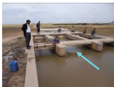
写真 2-2-18 この先、パイプラインとなる（低圧管路地区へ）
