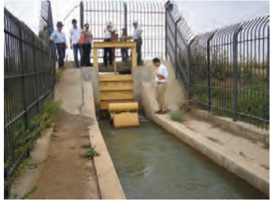
円借款整備地区（分水施設）
