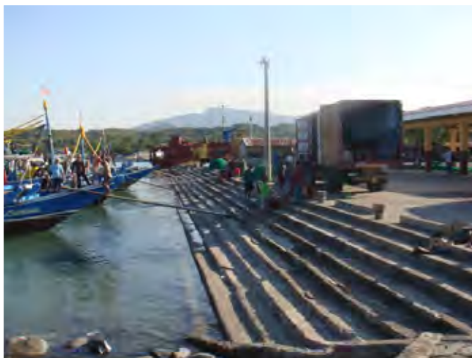
写真3 階段式岸壁（スアル漁港）
