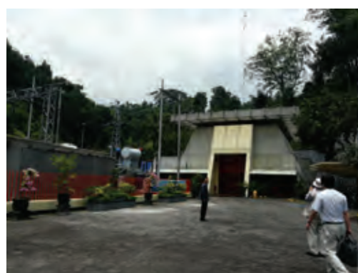
カリコントダム (2)
