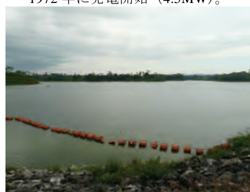
ラホールダム
