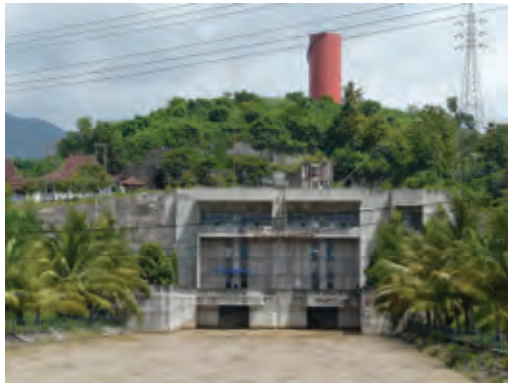
トルンアグンダム トルンアグン排水施設から取水し発電。 1991年に発電開始（36MW）。
