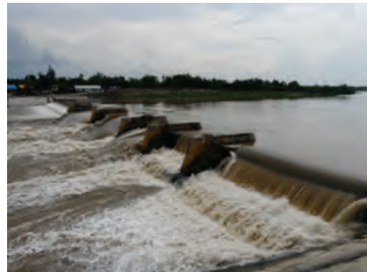
ムンチュリスゴム堰 ブランタス川中流域河川改修の一環で、ジャティムレゴム堰の下流に建設された。
