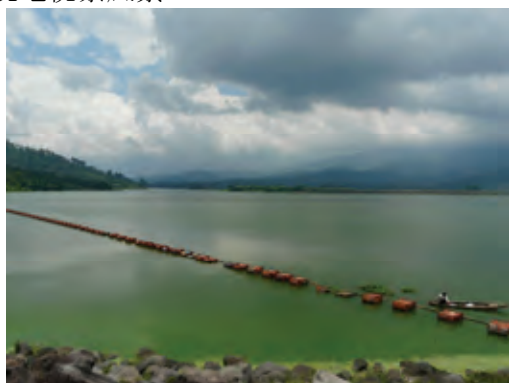
カリコントダム (1)
