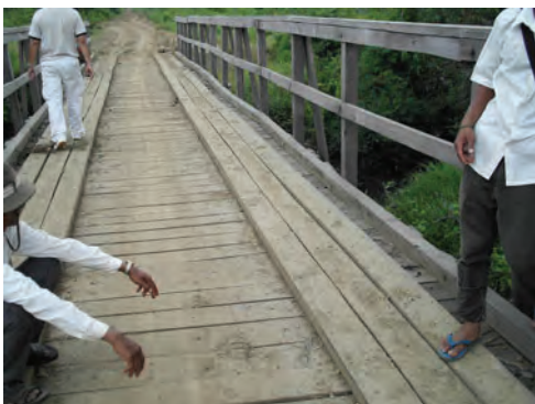
コミュニオンファンドによる木橋の建設事例。部材の材質・サイズ等仕様がプロジェクトよりやや低い。
