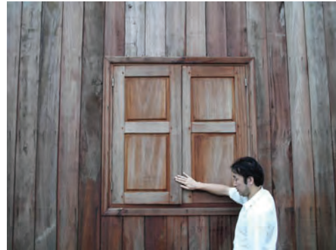
開閉に不具合がある窓（1カ所のみ）。蝶番の位置を上げるか、建具の下部を削ることで対応可能。
