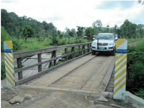
損壊した既存橋横に建造した幅3.5m・全長15m、現地仕様（最大積載荷重10t、耐久年数15年）の木橋。
