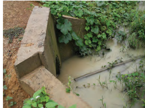
同左道路にコミュニンにより敷設されたカルバート。
