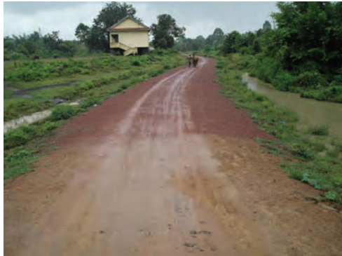
整備された道路。特に問題はない。
