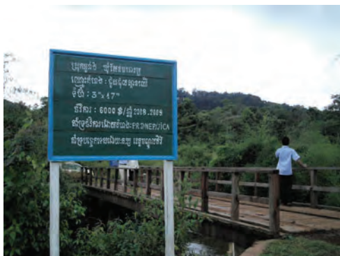
本プロジェクトによる橋改修工事を記した標識と現地仕様による木橋。
