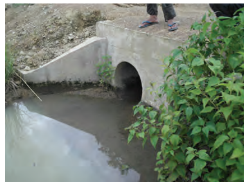
コミュニオンファンドによるカルバート敷設事例。周囲状況から判断すると、部材の径がやや小さい。
