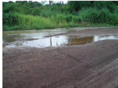
道路自身には問題はないが、周辺水路からの流水防止のために、側溝・カルバート等の整備が必要。
