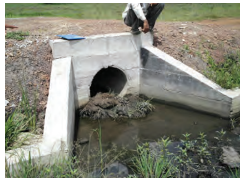
カルバート4。特に問題はない。写真は、水田の灌漑を目的とした草・土等による流水調整事例。
