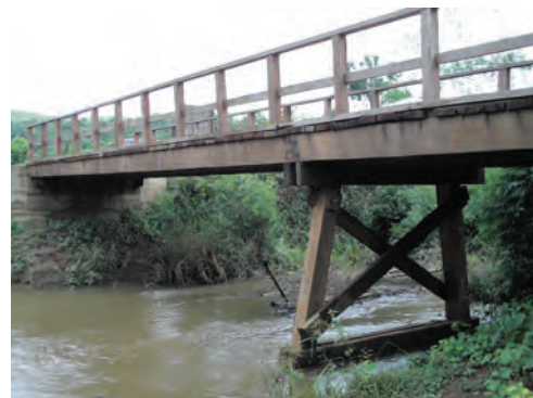
橋そのものには問題はない。持続的利用のため、河川内の清掃や道路等の周辺整備と維持管理は必要。
