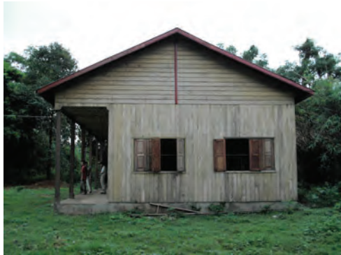
木造（コンクリート基礎・床）の図書室・集会室全景。建物に関して特に問題はない。
