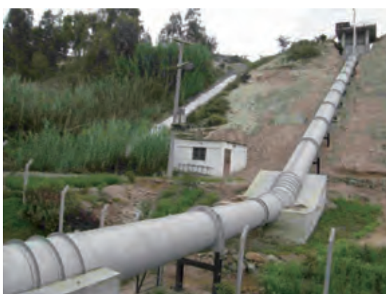
Proyecto de mini-hidroeléctrica (Perú)
