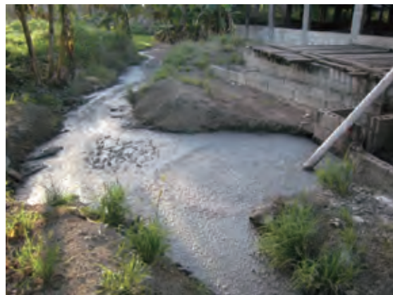
Laguna para el tratamiento de aguas residuales en la granja
