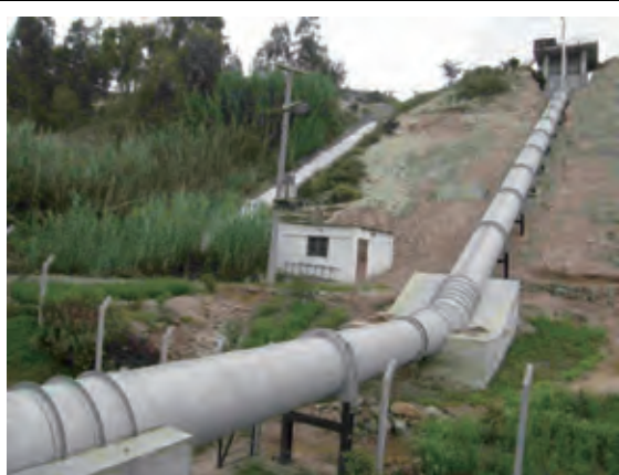
Proyecto de mini-hidroeléctrica (Perú)
