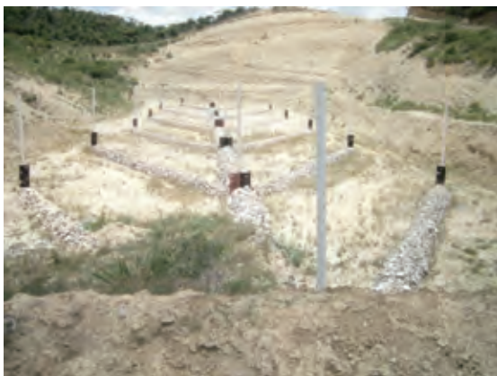
Obras en un relleno semi-anaeróbico (Provincia de Santiago)
