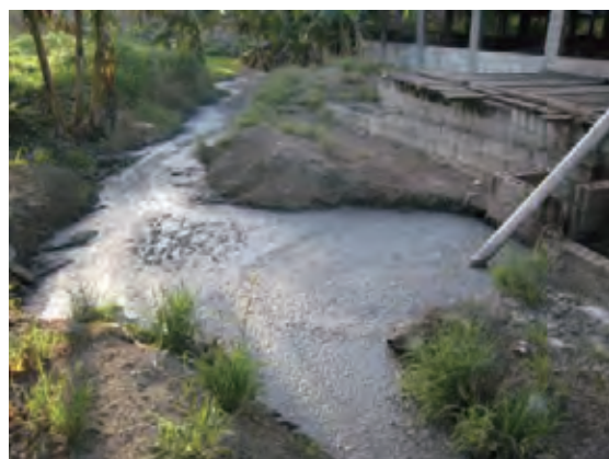
養豚場の廃水処理施設
