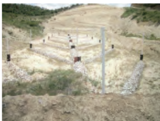
一般廃棄物準好気性埋立処分場建設状況 (サンチャゴ県)
