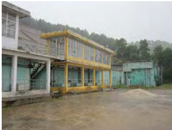
Nhà máy xử lý nước Vũng Áng hiện có Q=9,000m 3 /ngày, là nguồn nước của dự án
