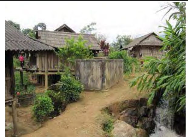
Khu vực cấp nước dự kiến (Bể chứa hiện có, bể này dùng để chứa nước suối)
