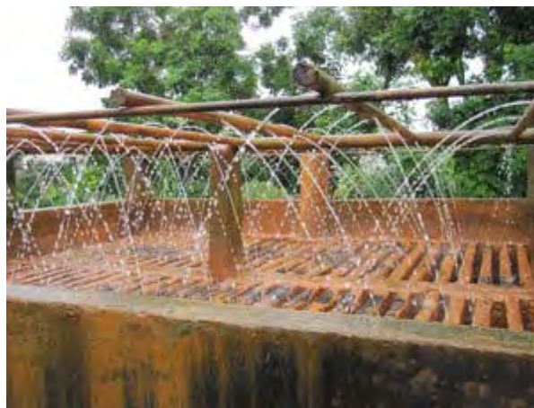
Nhà máy xử lý hiện có Sẽ được nâng cấp từ 250 lên 500m 3 /ngày
