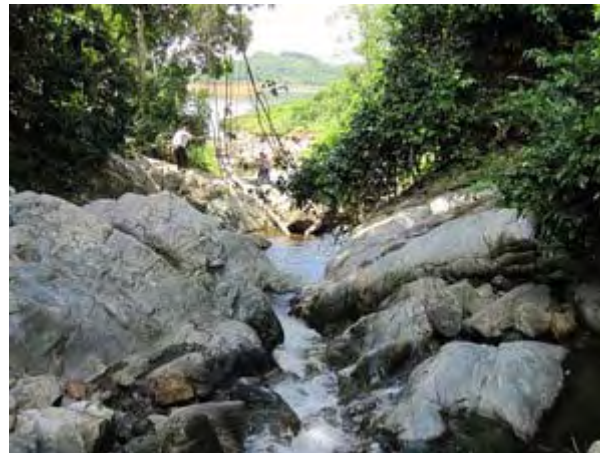
Vị trí hạng mục thu nước thô dự kiến Nằm bên bờ trái của suối Mã Tăng, Q=3,000m 3 /ngày, tự chảy (nhìn từ phía thượng nguồn)
