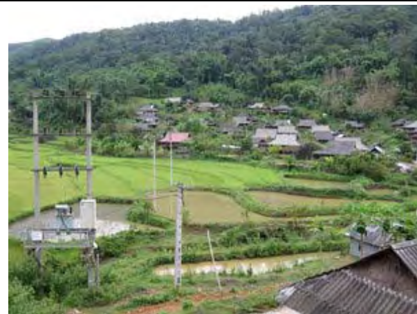
Khu vực cấp nước dự kiến
