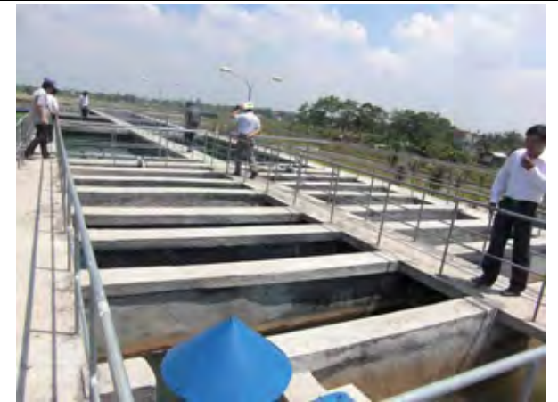
Nhà máy xử lý nước hiện tại Công suất Q=8,000m 3 /ngày
