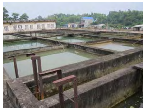
Nhà máy xử lý nước hiện có Sẽ được nâng cấp thông qua vốn của Na-Uy Q=15,000 đến 20,000m 3 /ngày sẽ là nguồn nước cho dự án
