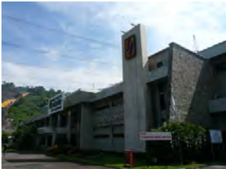
図 3.6-8 サグリン水力発電所建屋
