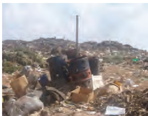
写真 4-10 簡易型ガス抜き管の埋設 10カ所ほど
