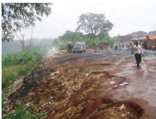
写真4-11 フエ地方郡政府の処分場 オープンダンピングで管理されていない。
