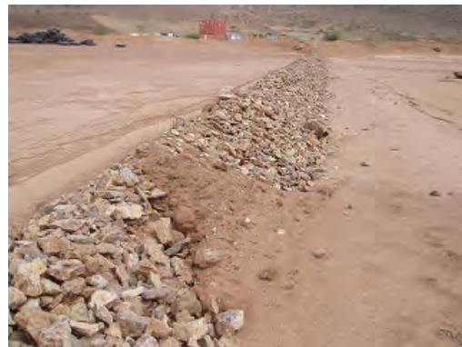
写真3-27 新処分場（浸出水集水管）
