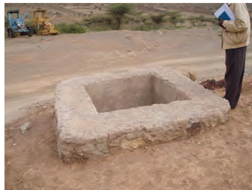
写真3-29 新規処分場（浸出水集水柵）
