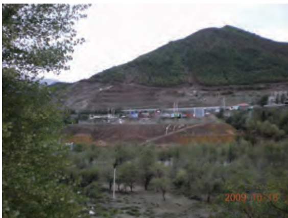
写真 5.6.9 Reps No.1 堆積場
