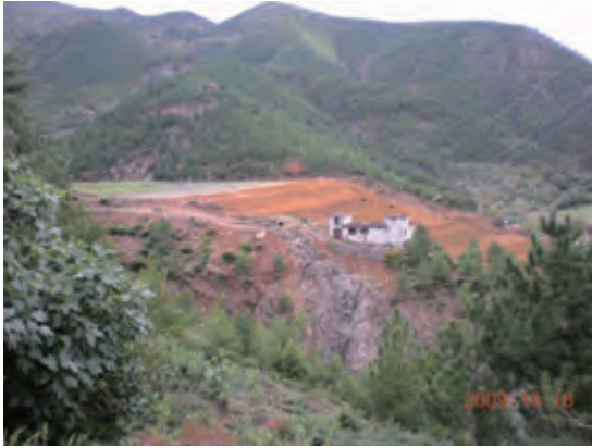
写真 5.6.11 Repts No.3 堆積場全景
