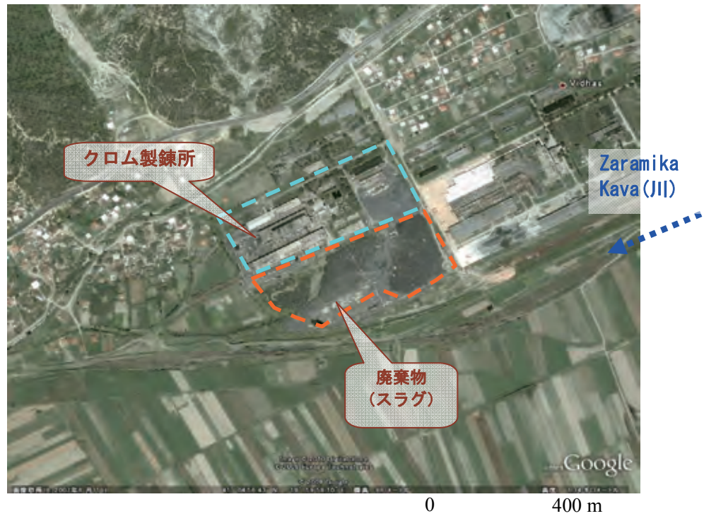
図 5.7.3 クロム製錬所及び廃棄物（スラグ）処分場
