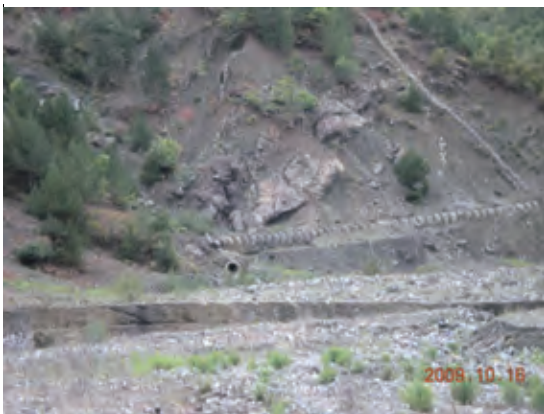
写真 5.6.13 No.3 堆積場山腹水路
