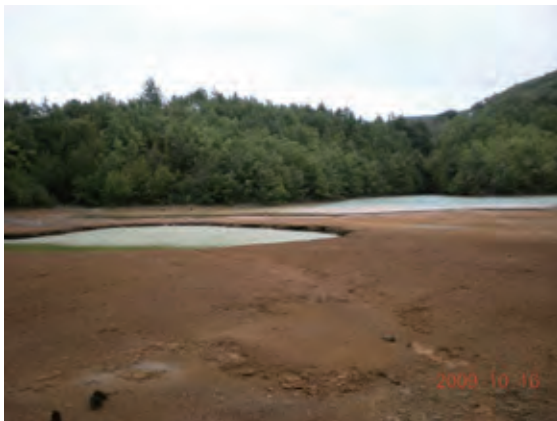
写真 5.6.17 堆積場内の陥没 (2 箇所) (径：約 20m、満水状態)
