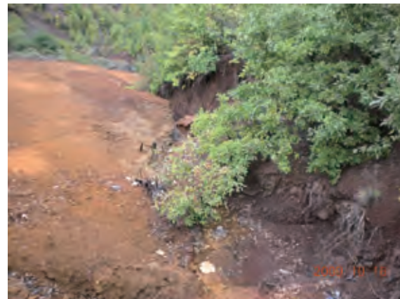
写真 5.6.18 堆積場右岸の浸食
