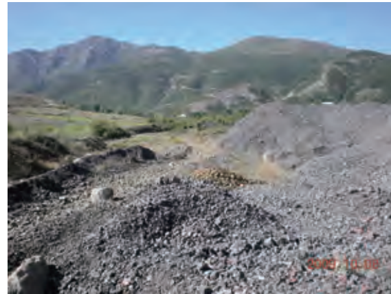
写真 5.6.4 スラグ堆積場と河川 (スラグの流出)
