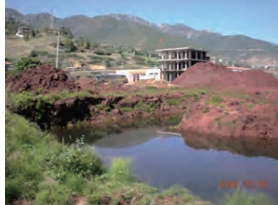
写真 5.6.8 貯鉱場および掘削箇所の湧水
