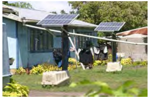
Ha'apai に設置された SHS
