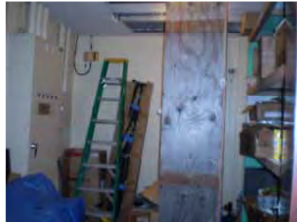
パワーコンディショナー設置予定スペース
