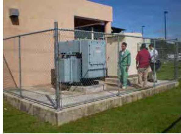
主変圧器及び電力計量箱
