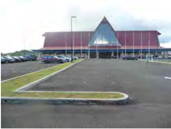
ターミナルビルと駐車場
