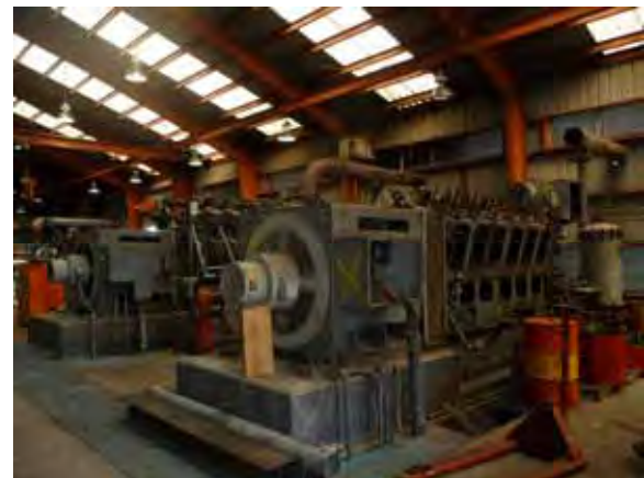
マラカル発電所
