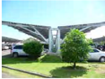
PV モジュール
