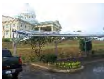
駐車場 PV モジュール
