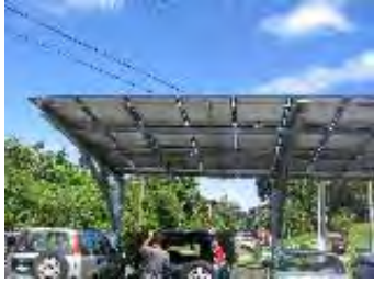
駐車場設置 PV モジュール
