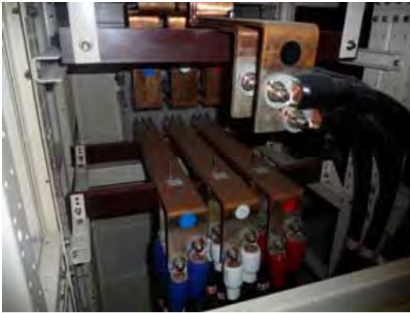
既設低圧分電盤内の連系点
