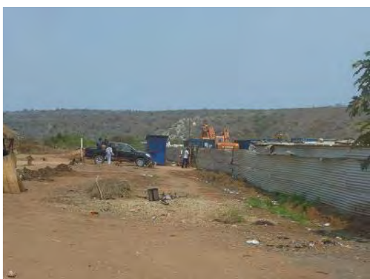
<綿花畑工事機材置場>
