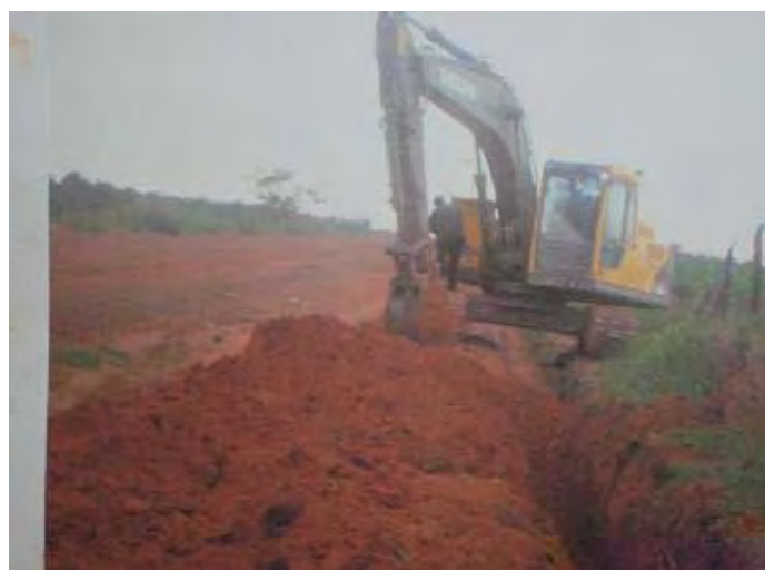
INAD が地雷除去をした後で 一般建設機械でケーブル埋設用溝を掘削する
