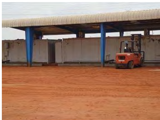
<完成近い新建屋・宿泊設備>
