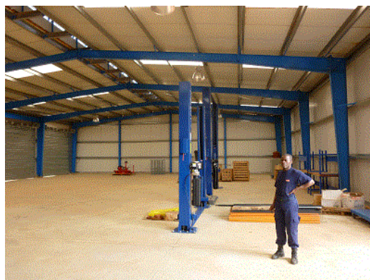
<完成近い機材整備工場>
