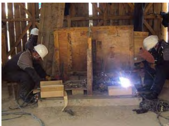
<溶接作業中のメカニック>
