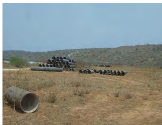
<導水管埋設工事>
