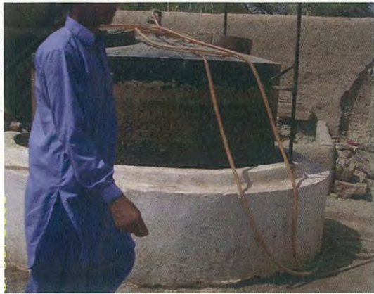
PDDC 農村内のバイオガスプラント
