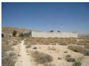
既存アインエルベイダ配水池 ここに井戸水源が集められ対象地 域に送水されている
