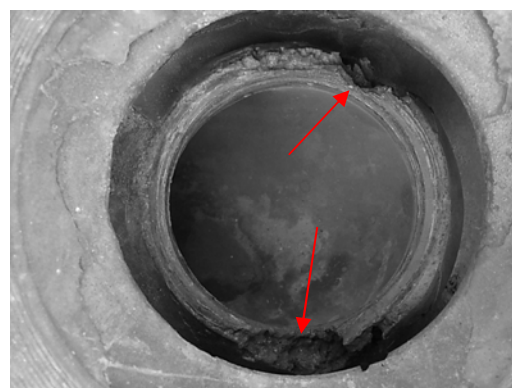
キャビテーションによる破損
