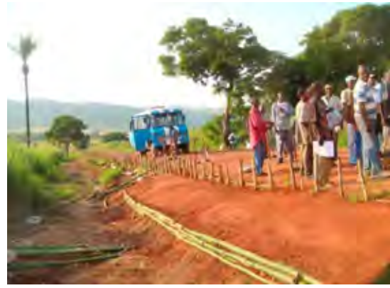
【Photo 10 – 2 ème jour de stage (cours pratique)】 Après la réparation (L=9.00m)
