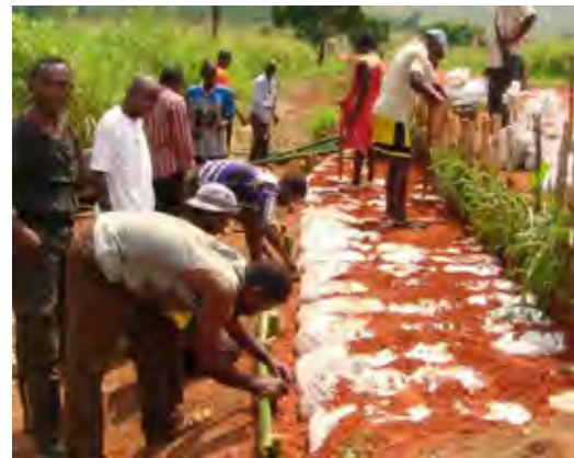
【Photo 11 – 2 ème jour de stage (cours pratique)】 Les participants compactent les sacs de sable et posent des bambous pour retenir la terre.
