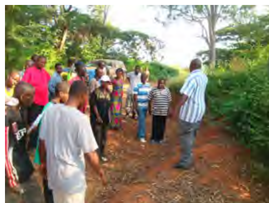
【Photo 6 – 1 er jour de stage (sur le site)】 L'homologue explique la rectification des fossés de drainage pour que l'eau ne stagne pas sur la route.
