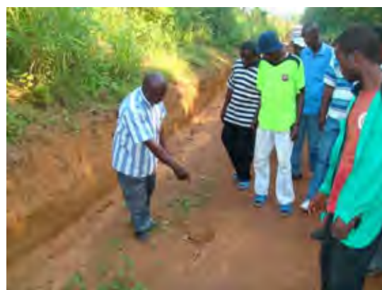
【Photo 5 – 1 er jour de stage (sur le site)】 L'homologue explique les réparations sur les parties érodées de l'accotement
