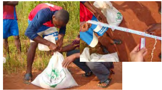
⑥ Nouer le sac de sable avec des Ficelles (40cm environ) fermement.
