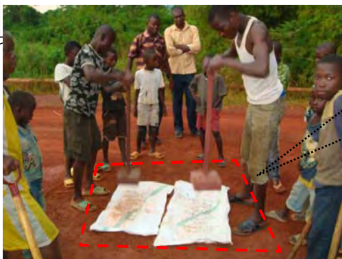
⑧ Compacter la couche finale.
