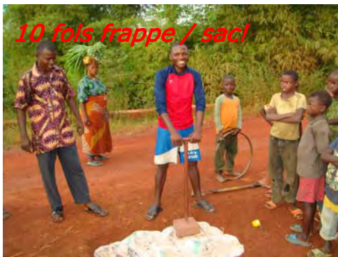
⑥ Compactage: 10 frappes par sac.
