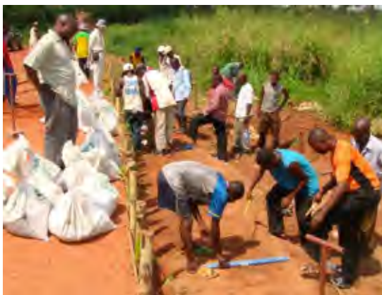
【Photo 9 – 2 ème jour de stage (cours pratique)】 Cantonniers et homologues supervisent la mise en place des sacs de sable
