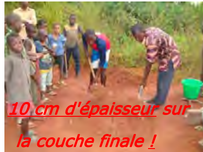
⑦ Couvrir la dernière couche de sac par le sol de latérite de 10 cm de profondeur.
