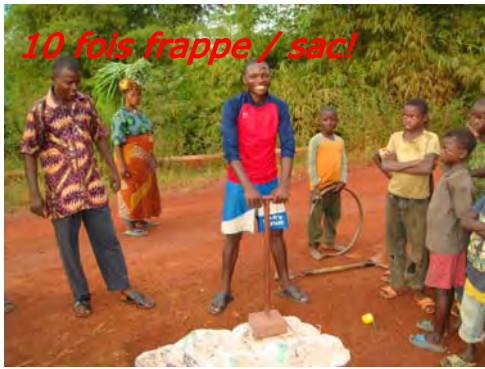
⑥ Compactage: 10 frappes par sac.
