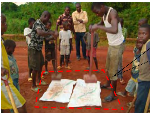
⑧ Compacter la couche finale.
