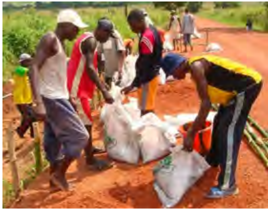
【写真-8 研修 2 日目（実技）】 初日に学んだ知識を活かして、土のうを作成する道路維持管理者
