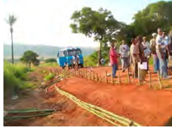
【写真-10 研修 2 日目（実技）】 改修後（施工延長 L=9.00m）
