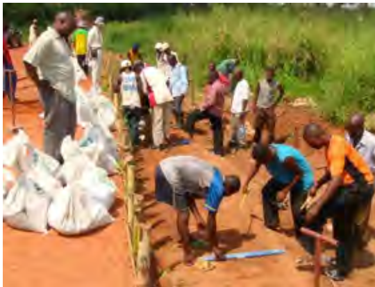
【写真-9 研修 2 日目（実技）】 土のうの配置を計算する道路維持管理者と、彼らの作業を監督する C/P
