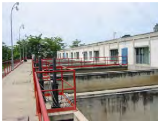
レンパ川浄水場の急速ろ過池
