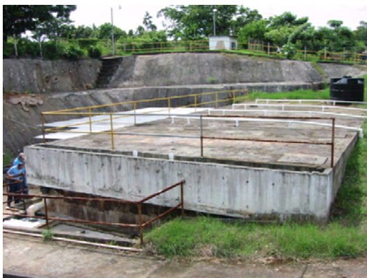
スペインの援助で建設されたインプティカ市の 下水処理場（嫌気性処理）
