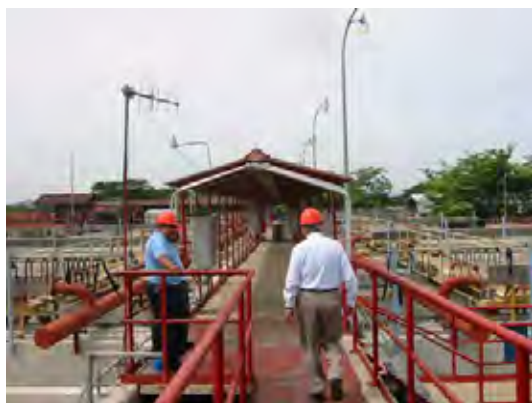
レンパ川浄水場の凝集沈殿池
