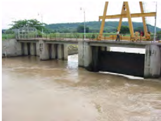
レンパ川浄水場取水口付近の取水堰
