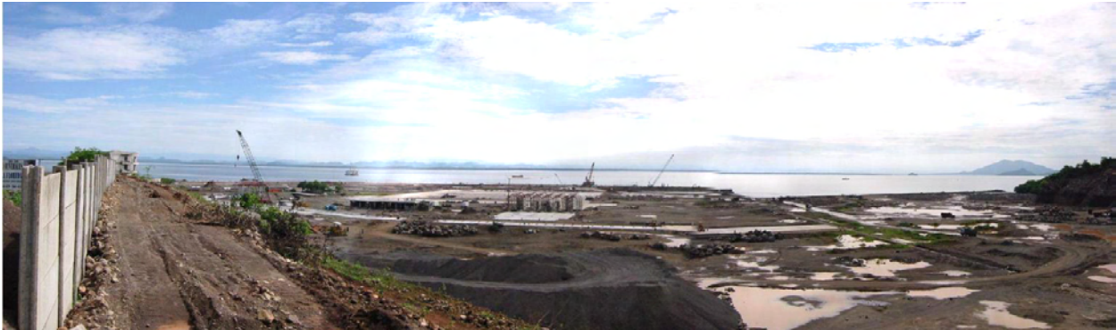
建設中のラウニオン港全景（2008年11月完成予定）
