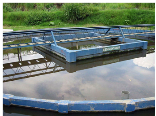
同下水処理場の最終沈殿池
