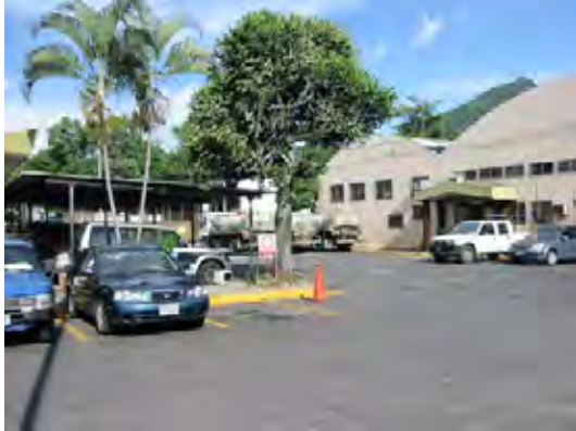
中部支局の事務所全景
