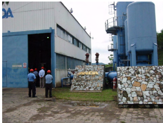
レンパ川取水口の送水ポンプ場
