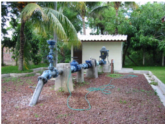
KfW プロジェクトで建設された井戸と配水管
