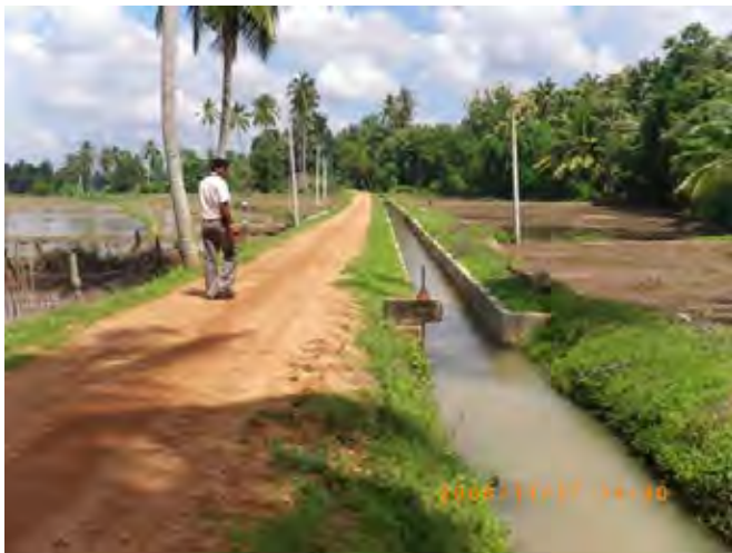
農民組織によって改修さ れた水路・農道
