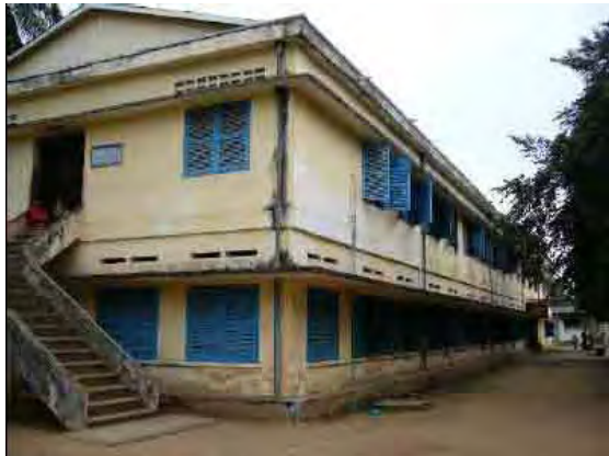
コンポンチャム州病院外観
