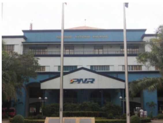
PNR 本部外観（1 階の一部が Tutuban 駅として使用されている）
