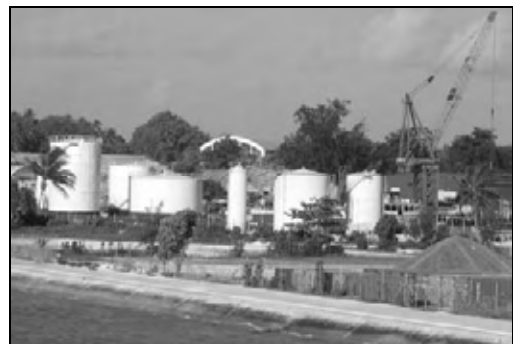
写真-19 石油備蓄基地
