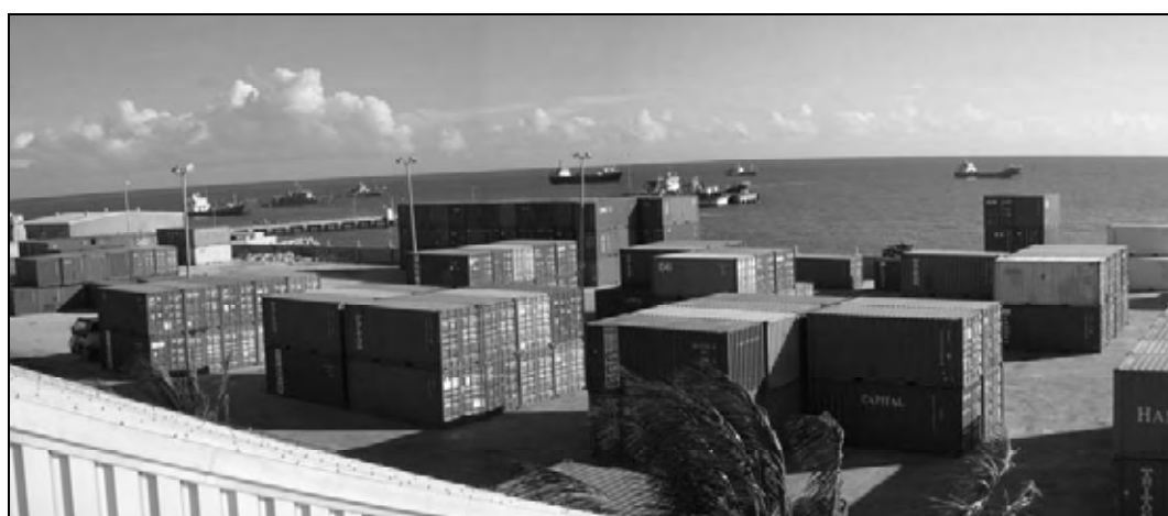
写真-3 コンテナヤードの全景
