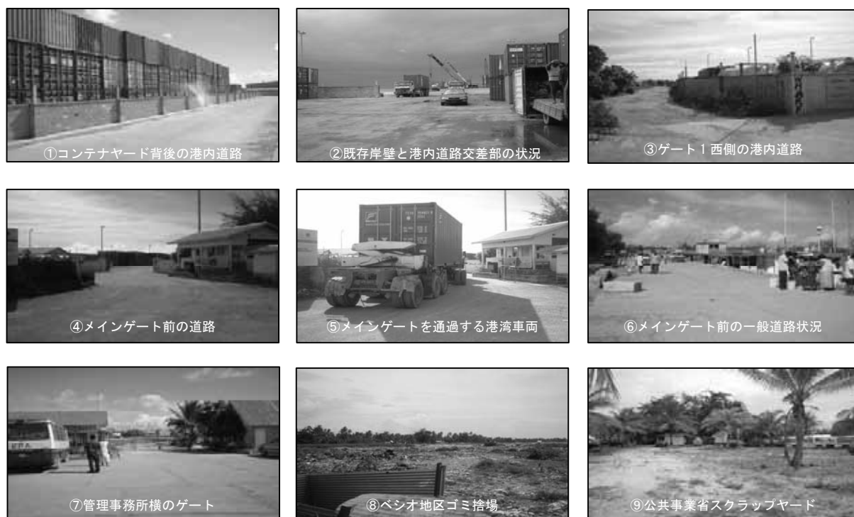
写真 3.2.4-1 動線計画上の主要地点及び関連施設の状況
