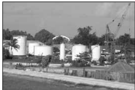
写真-19 石油備蓄基地
