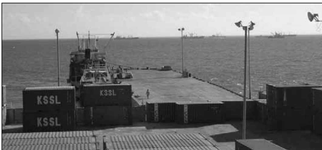
写真-2 岸壁施設の全景と計画施設の建設海域
