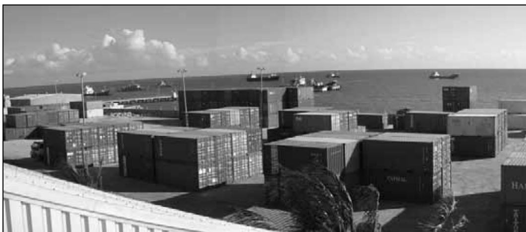
写真-3 コンテナヤードの全景
