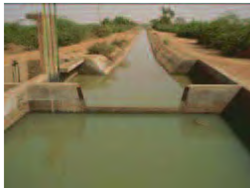
ポンプ場後方の分水施設と幹線水路
