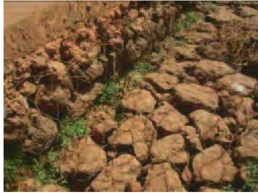
ダム上流（部分）
