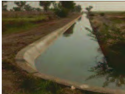
幹線水路 (延長 4km 間に橋が無い)
