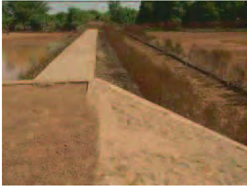
ダム右岸下流
