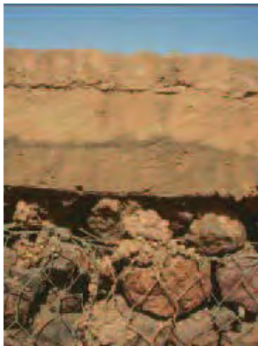
ダム上流（部分）
