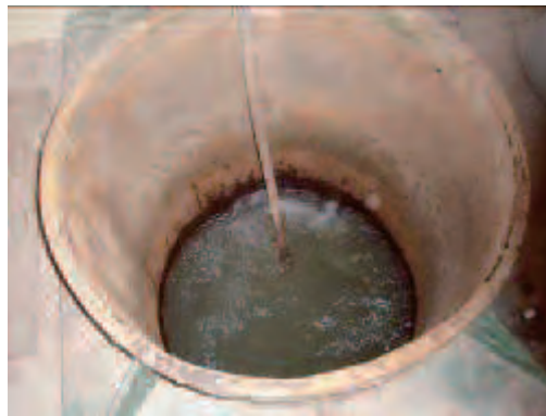
ポンプ稼動状況
