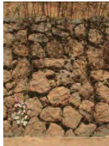
ダム下流（部分）
