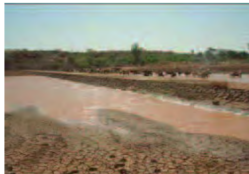
ダム左岸上流
