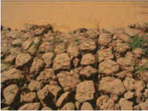
ダム下流（部分）
