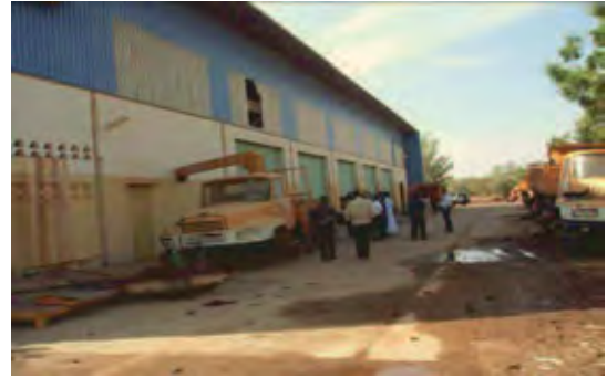
ONAHA 機材整備工場
