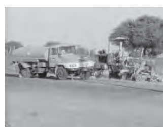
散水車、ブルドーザー
