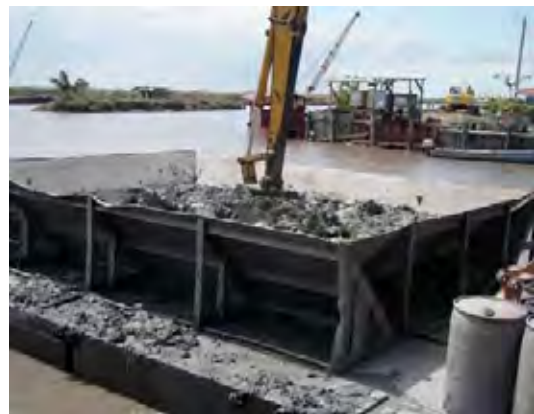
Ph-5 粘土～セメント混合状況（収容ビン内混合・Case1-1（セメント1袋/m 3 ）（10/26））：特に問題なく混合作業が進行した。
