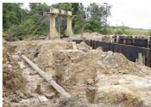
改修工事中の Lama 放流口
