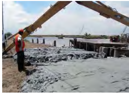
Ph-4 撤きだし状況～上面整形状況（10/26, Case2-1, 2-2, 2-3）：撤き出された粘土は塊状を保っている。上面の整形を問題なく行える程度に軟質である。
