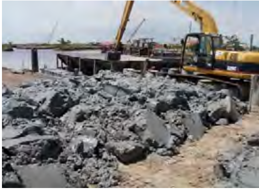
Ph-4 撤きだし状況～上面整形状況（10/26, Case2-1, 2-2, 2-3）：撤き出された粘土は塊状を保っている。上面の整形を問題なく行える程度に軟質である。
