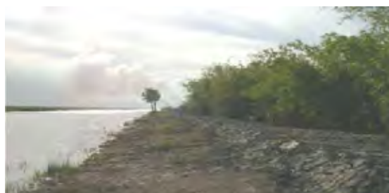
上流斜面の状況（施工後約2週間）
