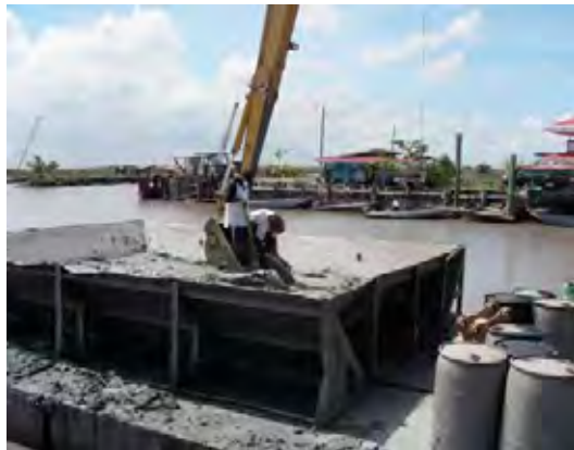
Ph-5 粘土～セメント混合状況（収容ビン内混合・Case1-1（セメント1袋/m 3 ）（10/26））：特に問題なく混合作業が進行した。
