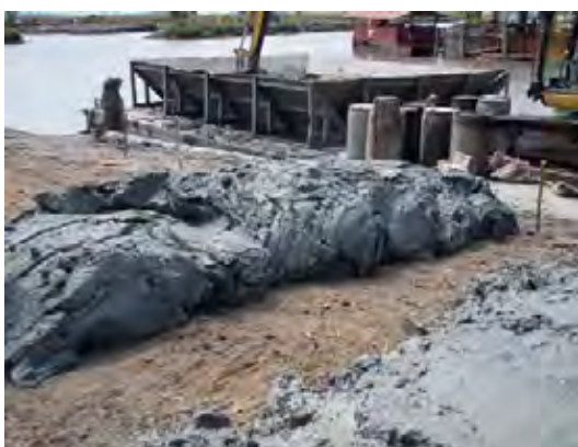
Ph-6 粘土～セメント混合後、撤き出された状態（収容ビン内混合、Case1-1(10/26)）よく練り混ぜられたことを反映した様相を呈するが、 部分的には粘土の中に取り込まれていないセメント粒子もある。
