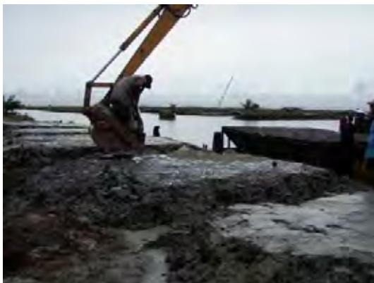
Ph-12 Case2-1 (セメント 1 袋/m 3 ) のセメント混合状況と撒きだし時の状態 (10/31) : 前夜にかなり強い雨があったため、混合作業に入る仮置き土の含水比状態が前 2 ケース (Case2-2, 2-3) よりも少し高めとなった。混合状態は Case2-2, 2-3 よりも良好である。混合作業に 12 分を費やし撒きだし、整形に入った。
