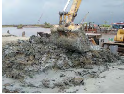
Ph-11 Case2-2 (セメント 2 袋/m 3 ) のセメント混合状況と撒きだし時の状態 (10/30)
