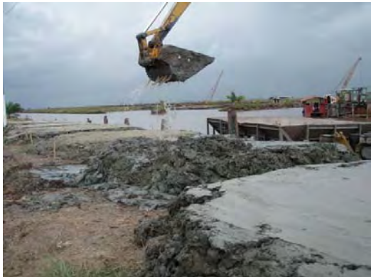
Ph-11 Case2-2 (セメント 2 袋/m 3 ) のセメント混合状況と撒きだし時の状態 (10/30)
