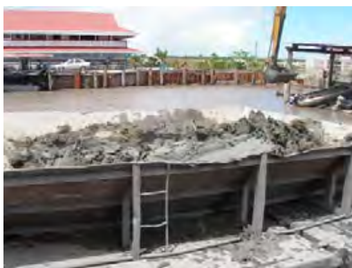
Ph-9 Case1-3 (セメント 3 袋/m 3 ) のセメント混合状況と撒きだし時の状態 (10/27)：収容ビン内での混合が徐々に困難となり、やむを得ず少量を3度加水した。撒き出された粘土塊の回りには、取り込まれていないセメント粒子が目立つ。撒きだしとして並べられた粘土塊には、Case1-1 のようなよく練り混ぜられた印象を与える様相は見られない。少量の水を3度かけて表面を整形した。
