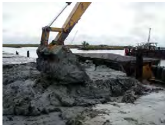
Ph-12 Case2-1 (セメント 1 袋/m 3 ) のセメント混合状況と撒きだし時の状態 (10/31) : 前夜にかなり強い雨があったため、混合作業に入る仮置き土の含水比状態が前 2 ケース (Case2-2, 2-3) よりも少し高めとなった。混合状態は Case2-2, 2-3 よりも良好である。混合作業に 12 分を費やし撒きだし、整形に入った。
