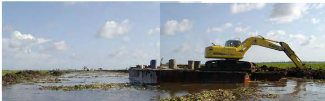
貯水池内水路の掘削
