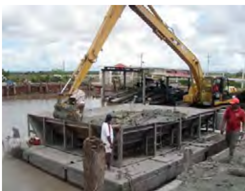
Ph-8 Case1-2 (セメント 2 袋/m 3 ) のセメント混合状況と撒きだし時の状態 (10/27)：収容ビン内での混合が徐々に困難となり、やむを得ず少量を一度加水した。撒き出された粘土塊の回りには、取り込まれていないセメント粒子が目立つ。少量の水をかけて表面を整形した。
