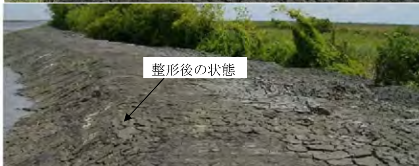
超ロングアーム・バックホー～台船方式による現在進行中の堤体
