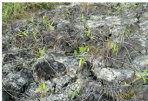
下流側盛土面の状況
