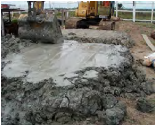
Ph-10 Case2-3 (セメント 3 袋/m 3 ) のセメント混合状況と撒きだし時の状態 (10/30)
