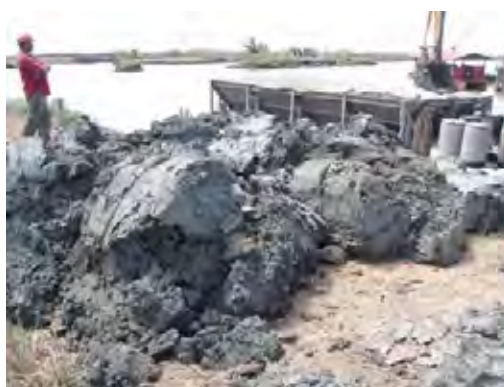
Ph-9 Case1-3 (セメント 3 袋/m 3 ) のセメント混合状況と撒きだし時の状態 (10/27)：収容ビン内での混合が徐々に困難となり、やむを得ず少量を3度加水した。撒き出された粘土塊の回りには、取り込まれていないセメント粒子が目立つ。撒きだしとして並べられた粘土塊には、Case1-1 のようなよく練り混ぜられた印象を与える様相は見られない。少量の水を3度かけて表面を整形した。
