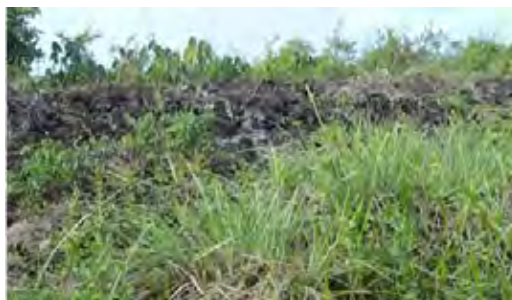
上流斜面の状況（施工後約3年）
