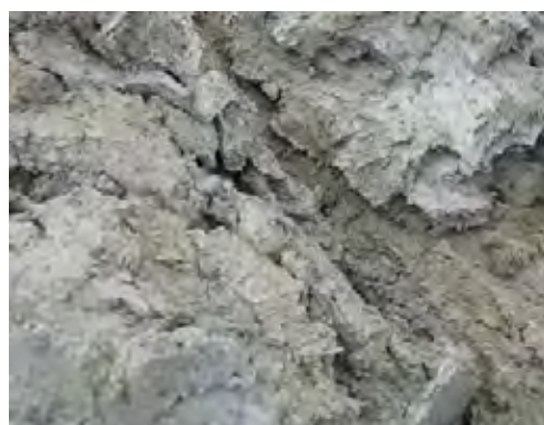
Ph-8 Case1-2 (セメント 2 袋/m 3 ) のセメント混合状況と撒きだし時の状態 (10/27)：収容ビン内での混合が徐々に困難となり、やむを得ず少量を一度加水した。撒き出された粘土塊の回りには、取り込まれていないセメント粒子が目立つ。少量の水をかけて表面を整形した。
