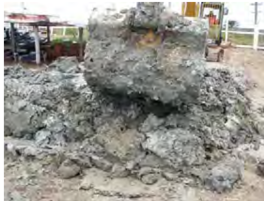
Ph-10 Case2-3 (セメント 3 袋/m 3 ) のセメント混合状況と撒きだし時の状態 (10/30)
