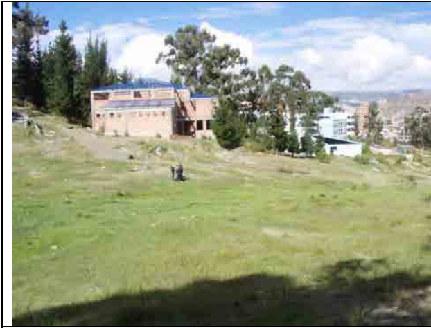
PVシステム設置予定地、北側から撮影(UMSA)
