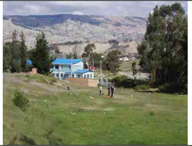
PVシステム設置予定地、東側から撮影(UMSA)
