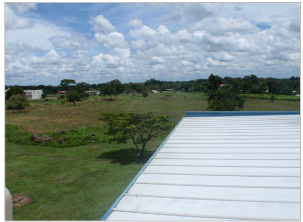
ベリーズ大学構内のプロジェクトサイト全景 (南側、講堂屋上から)
