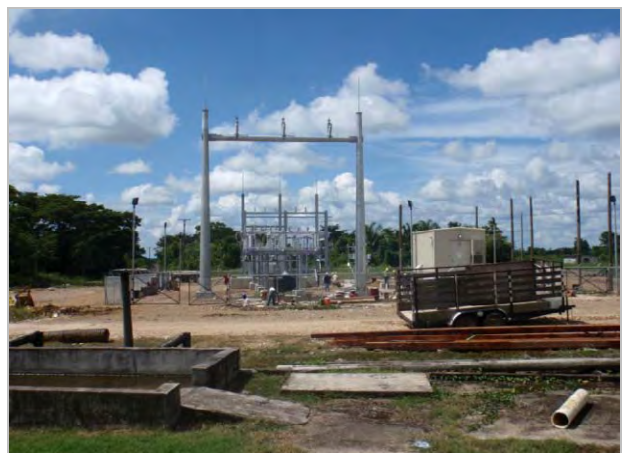
新規ベルモパン変電所(建設中)
