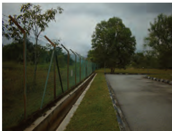
バンダー・バルー・バンギーSec.9 処理場 (EA 法で稼動中、集約化処理場予定地)
