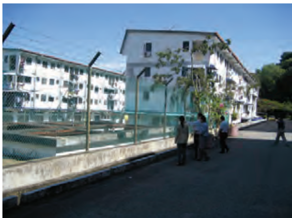
キナマウント団地処理施設 (長時間バツ気、散気装置は停止中)
