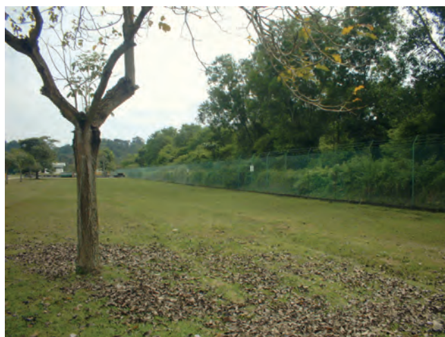
バンダー・バルー・バンギー Sec.15 処理場 (エアレーテド・ポンド法で稼動中、集約化 処理場予定地)
