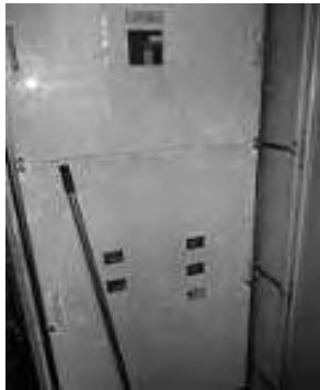
主幹開閉器 400A 分岐 5 回路
