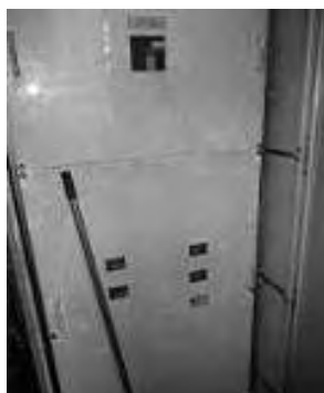
主幹開閉器 400A 分岐 5 回路
